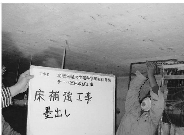
CFRP 帯板接着位置墨出し作業
