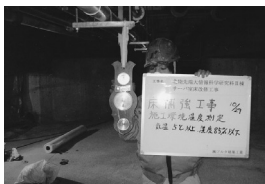
施工環境の確認
