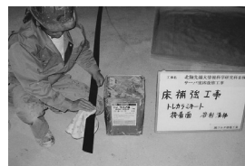
CFRP 帯板の清掃
