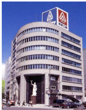
新家工業本社ビル(大阪) (新家工業(株)提供)
