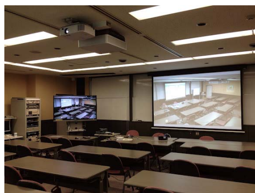
図 6. プロジェクタ設備を追加後のコラボレーションルーム 7
