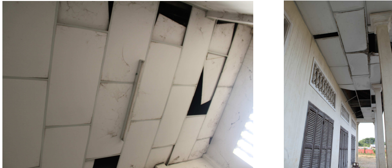
図21 建物内外の天井の様子
