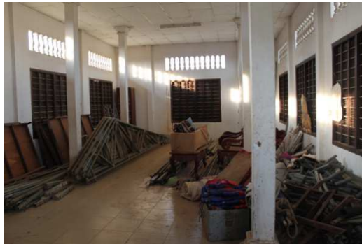
図19 学習センター設置予定の建物の内部
