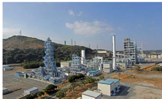
図 3 EAGLE パイロット試験設備外観
