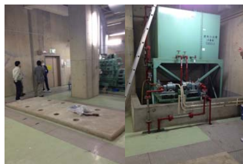
図 5. 電気室の様子
