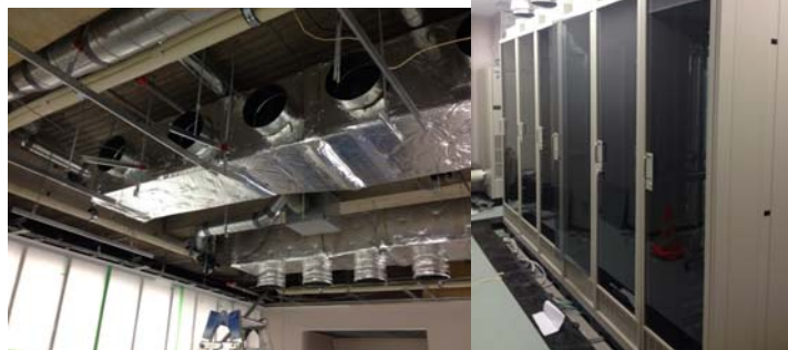
図3. ラック敷設工事の様子
