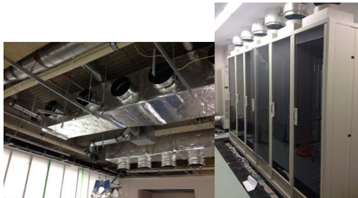
図3. ラック敷設工事の様子
