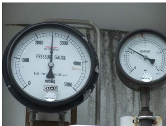
図 4. ガス取り用液体窒素貯槽に付属しているメータ。左が液量計、右は内圧計。液量計の単位は mmAq（水に換算して何 mm の高さ分の上下圧力差があるかを表示）である。
