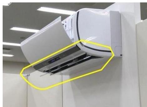
気流の通り抜けない家具を検出し、上向きに風向を調整
