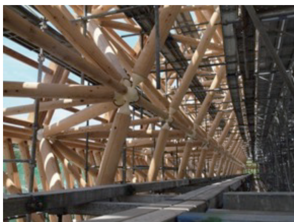
写真-13 トラスの立ち上がり部
