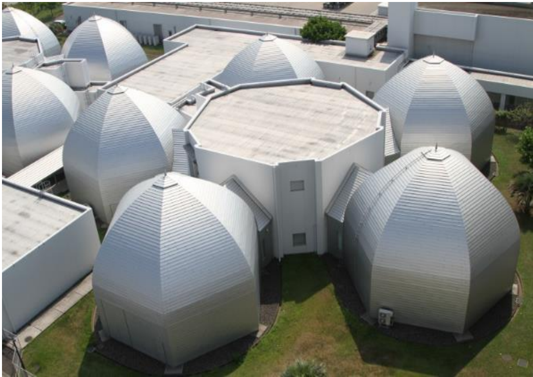
図 16 NMR が設置されている中央 NMR 棟 出典：(理化学研究所 NMR 施設 2018)
