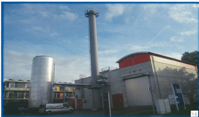
図4 フライブルグ市のコージェネ発電所 （燃料：木質チップ、電気と温水を併給する）
