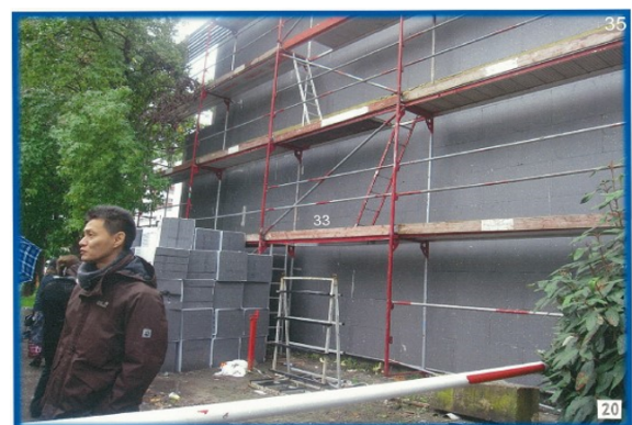
図5 フライブルグ市は古い集合住宅に 断熱材を張る）
