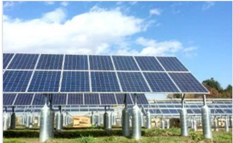
図 3 太陽光発電所の顔認証システム
