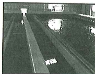
室内にあるろ過池
