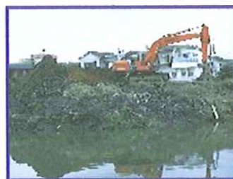
川を広げる工事
