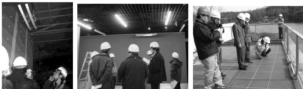
写真 3-5 タスクフォースによる現地設置状況の確認風景
