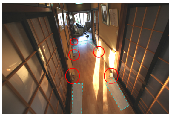
図6 廊下へのアンテナ設置 (RFID リーダ装置の壁面への取付け前)
