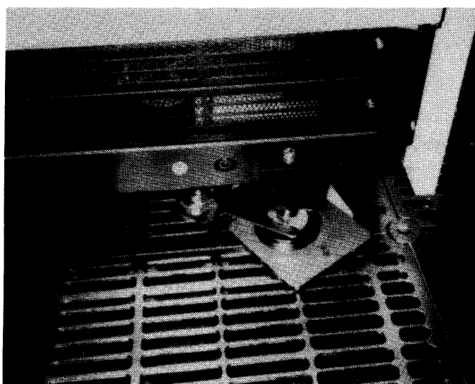
図3 グレーチングフロアでの設備固定における例
