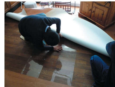
図 8 GH 廊下への RFID マットの導入 Fig. 8 The introduction of RFID mats to the corridor of a group home.
