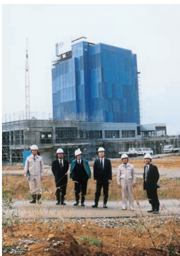
研究棟建設状況(平成3年10月)
