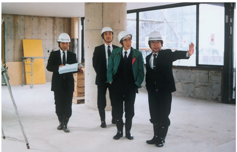
講義棟建設状況(平成3年10月)
